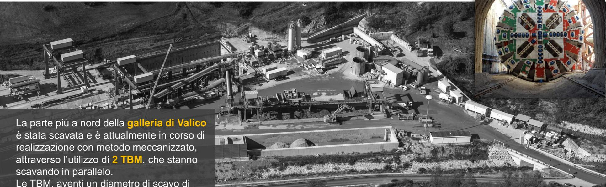
La parte più a nord della **galleria di Valico** è stata scavata e è attualmente in corso di realizzazione con metodo meccanizzato, attraverso l'utilizzo di **2 TBM**, che stanno scavando in parallelo.
